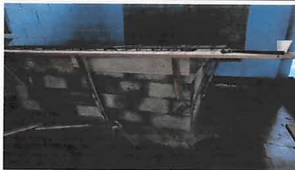
Foto 6: ELABORACIÓN DE PASAMANO DE CONCRETO
