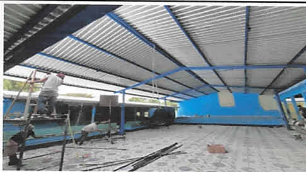
Foto 2: MANTENIMIENTO A ENERGIA ELECTRICA EN GALERA
